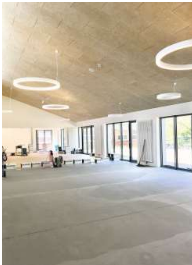
In der neuen Mensa wird noch ein Holzboden verlegt, dann kann es auch hier so richtig los gehen. Fotos: Fleischmann
