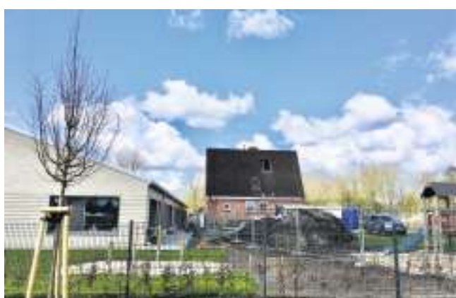
Das alte KiTa-Gebäude von 1950 (re.) wird demnächst abgerissen.
